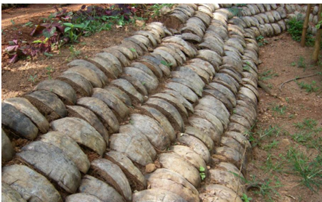
bෞද්ධ 06 - පොල්ලෙලි අල්ලා සකසන ලද පාංශු බාධනය වැළැක්වීමට යොදා ඇති වැටියකි.
